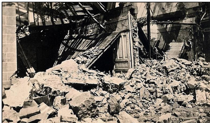
Puin lag over de weg verspreid - de plankenvloer staat schuin tegen de binnenmuur.
